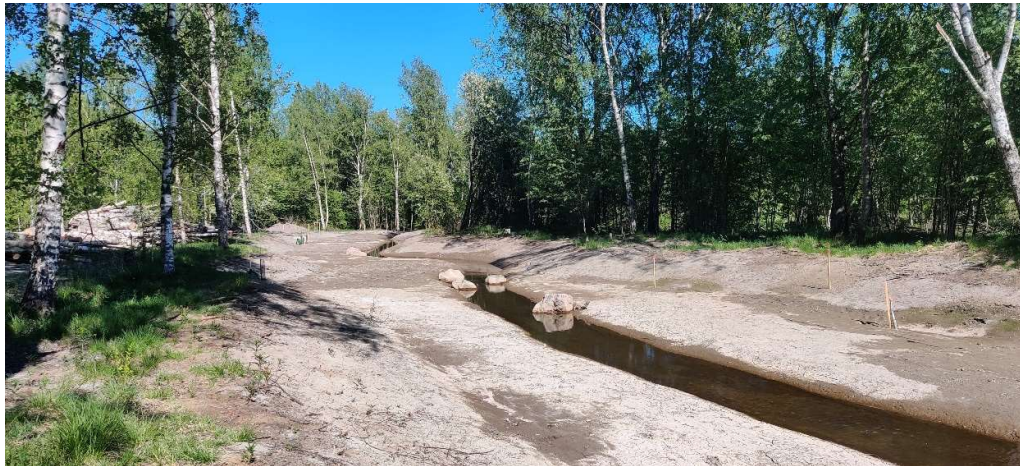
Kuva 7 Gräsanojan juuri valmistunutta, kunnostettua osuutta Seiliniityssä 21.5.2024 / Mari Räsänen / Espoon kaupunki
