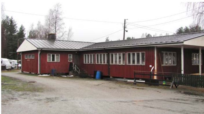
Kerhorakennuksen vesikatto valmiina syksyllä 2018
