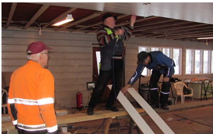
Salin kattolevyjen kiinnitystä. Kuvassa vasemmalta Ismo Sainio, Jorma Elovaara ja Kauko Seger.
