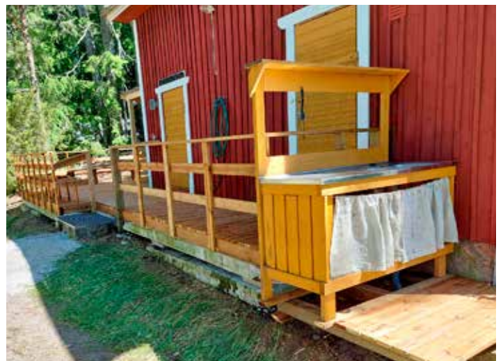
Raatalassa uusittiin tänä keväänä vanha terassi ja rakennettiin uusi.
