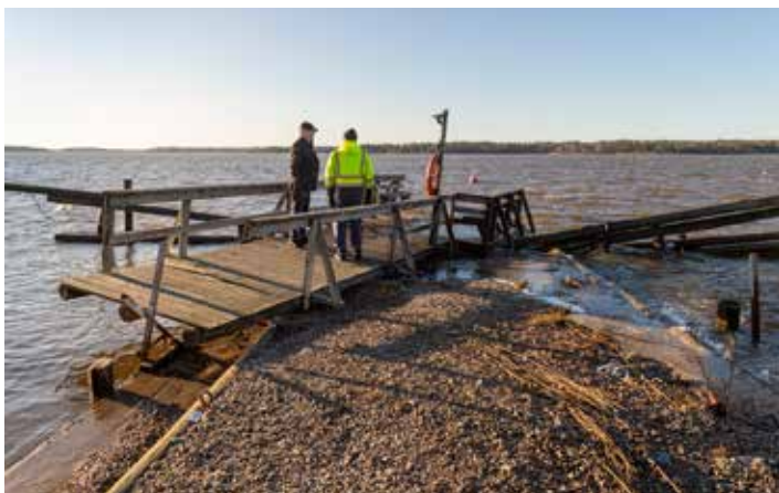
Reijo Silokoski ja Lasse Aaltonen tarkastelevat rikkoutunutta päälaituria.
