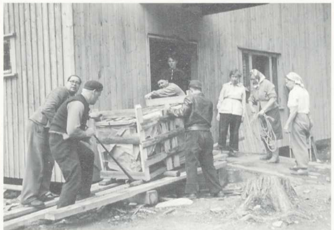
Päärakennuksen keittiön hellaa siirretään sisälle. Kuva vuodelta 1955.
