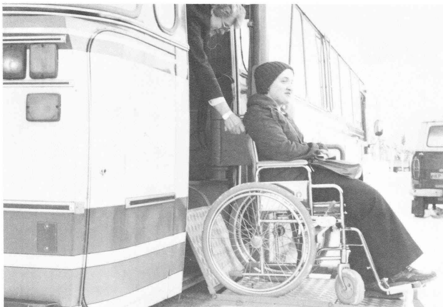
Maan ensimmäinen Länsilinjojen omistama Invabussi aloitti kuljetuksensa Tampereella toukokuulla 1981. Autossa on 11 pyörätuolipaikkaa, se on varustettu hissillä ja muilla mukavuuksilla.
