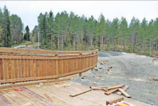
Siltojen uusimisen yhteydessä parannetaan latuprofiilien turvallisuutta.
