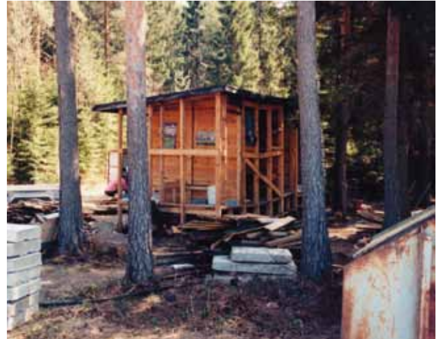
Aina ei voi rakentaa, vaan pitää myös purkaa, kuten tässä vanhan puuceen purkutyö.
