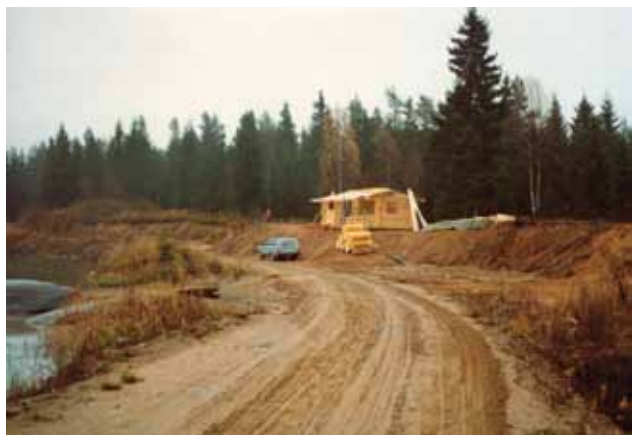
Aluksi oli tilaa rakentaa. Pikkusauna valmistumassa.
