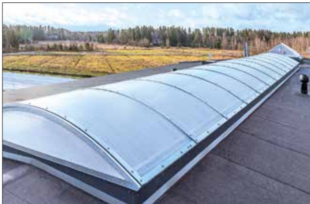
Tuotekehityksessä yhtenä painopisteenä on Keraplast UAB:n (Vilna) jatkuvat kattoikkunat. Kuva valmistuvan terassitehtaan katolta Orimattilassa.
