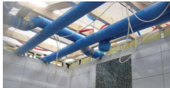
Putkituksien teossa pääsee tehdastyö parhaiten oikeuksiinsa.
