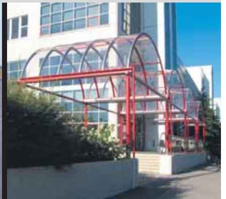
Akryyli- ja PC-levyt sopivat kaareviin lasituksiin. Kuvassa STYK toimitilojen sisäänkäynti.
