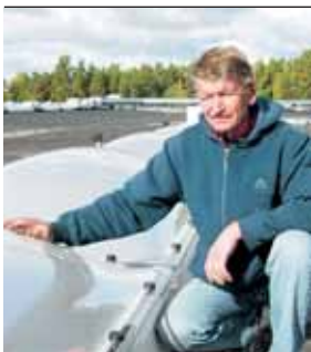
Kattovalokuvuilla voi kätevästi järjestää päivänvalon mm. tehdashalleihin.
