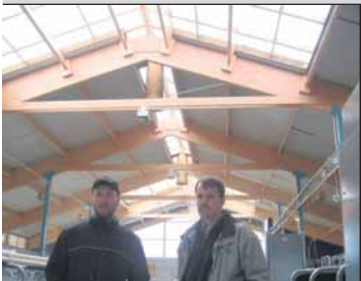
Nykyaikaiset navetat ovat valoisia. Ikkunoina käytetään PC-kerroslevyä. Kuvassa artjärveläinen isäntä Ari Isotalo ja Keraplastin Jari Leppänen.
