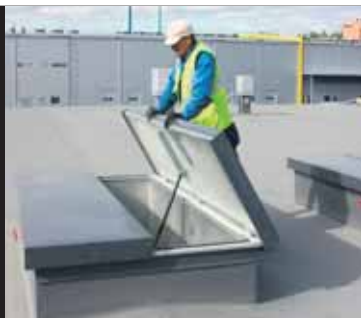
Teollisuus- ja varastohallien katoilla tarvitaan savunpoistoluukkuja tulipalon varalta.
