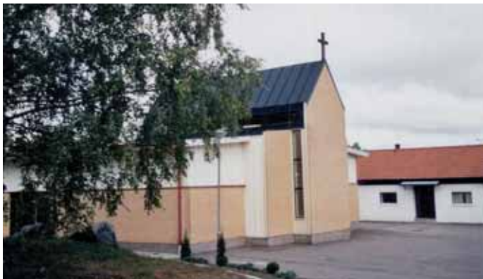
Knivstan rukoushuone syntyi korottamalla tehdasrakennusta. Oikealla entinen konttoritalo, nykyinen monitoimitila Vita Villa.
