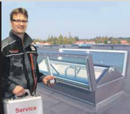
Savunpoistoluukkuja tulee huoltaa ja koelaukaista kerran vuodessa. Keraplastilla on oma huolto-osasto, jonka esimies on Reijo Kantoluoto.
