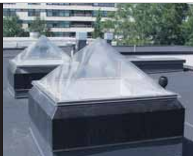
Ilmeikkäitä akryyli pyramidi kattoikkunoita Tampereen keskussairaalan katolla.
