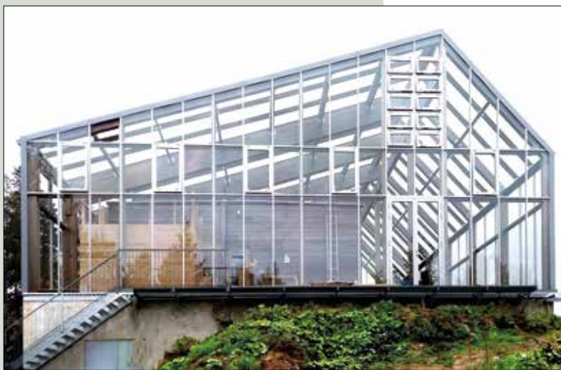
Mielikuvitus, luovuus ja rohkeus voi tuottaa huikaita asioita. Keraplast toimitti lasirakenteet Porvoon kasvihuonetaloon.
