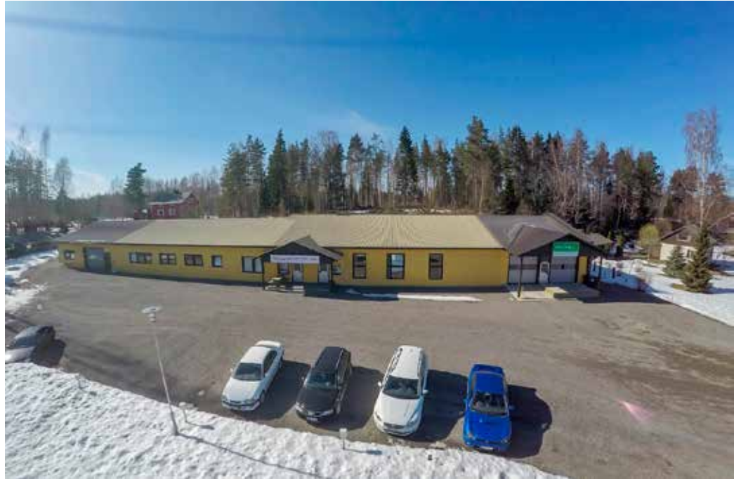
Padas-keittiöiden tuotantorakennus Maakeskenraitin varrella; oikella uusi laajennusosa.
