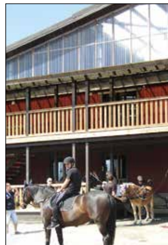
Okeroisten ratsastuskoulun valoikkunat
