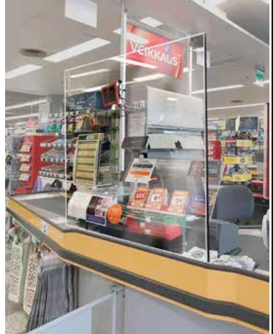
K-Supermarket Orimattilan pisarasuojapleksit toteutettiin 5 mm akryylilevystä.
