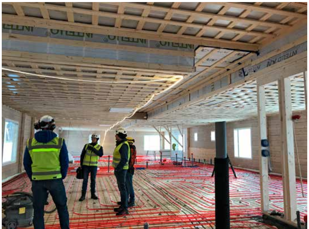
Hoivarakentajien liiketoimintajohtaja Kalle Kempainen ja talotekniikkajohtaja Arto Hievanen Siilinjärven hirsipäiväkotityömaalla tekemässä tarkastusta ennen lattiavalua.
