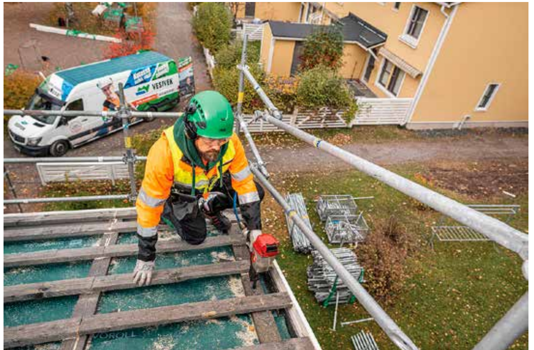
Vesivek otti ensimmäisenä käyttöön rakennustelineet putoamissuojauksena.
