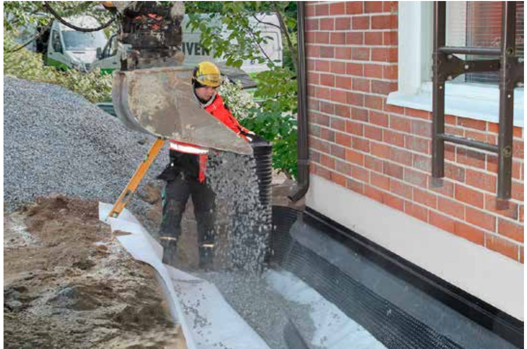
Salaoja-asennus jopa 2 päivässä.
