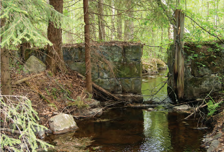
Moksjärven pato kuvattuna yläjuoksun puolelta (Kaikki jutun valokuvat Juhani Päivänen).
