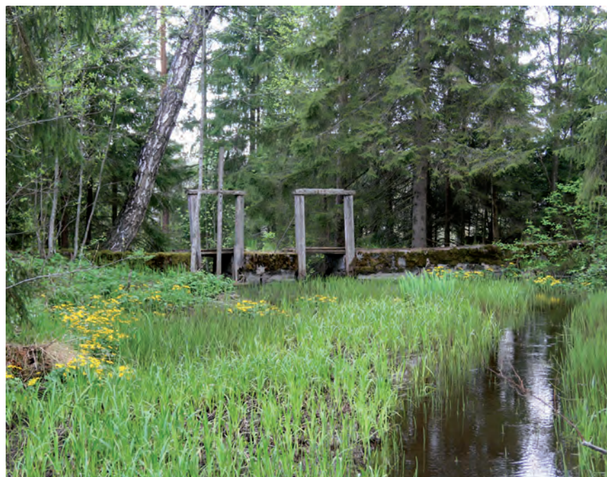
Korkeakosken pato kuvattuna yläjuoksun puolelta. Vasemmalla säännöstelty patoaukko, oikealla tulva-aukko.
