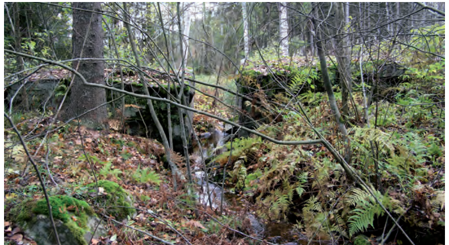
Hauklammen pato kuvattuna alajuoksun puolelta.
