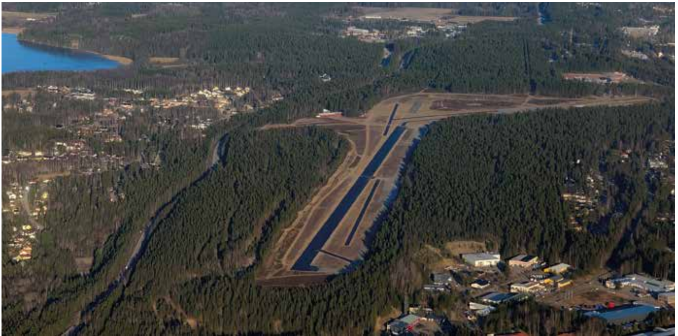
Nummela lentokentän uusi asfaltti. Kuva Nummela Lentokenttäyhdistys ry.
