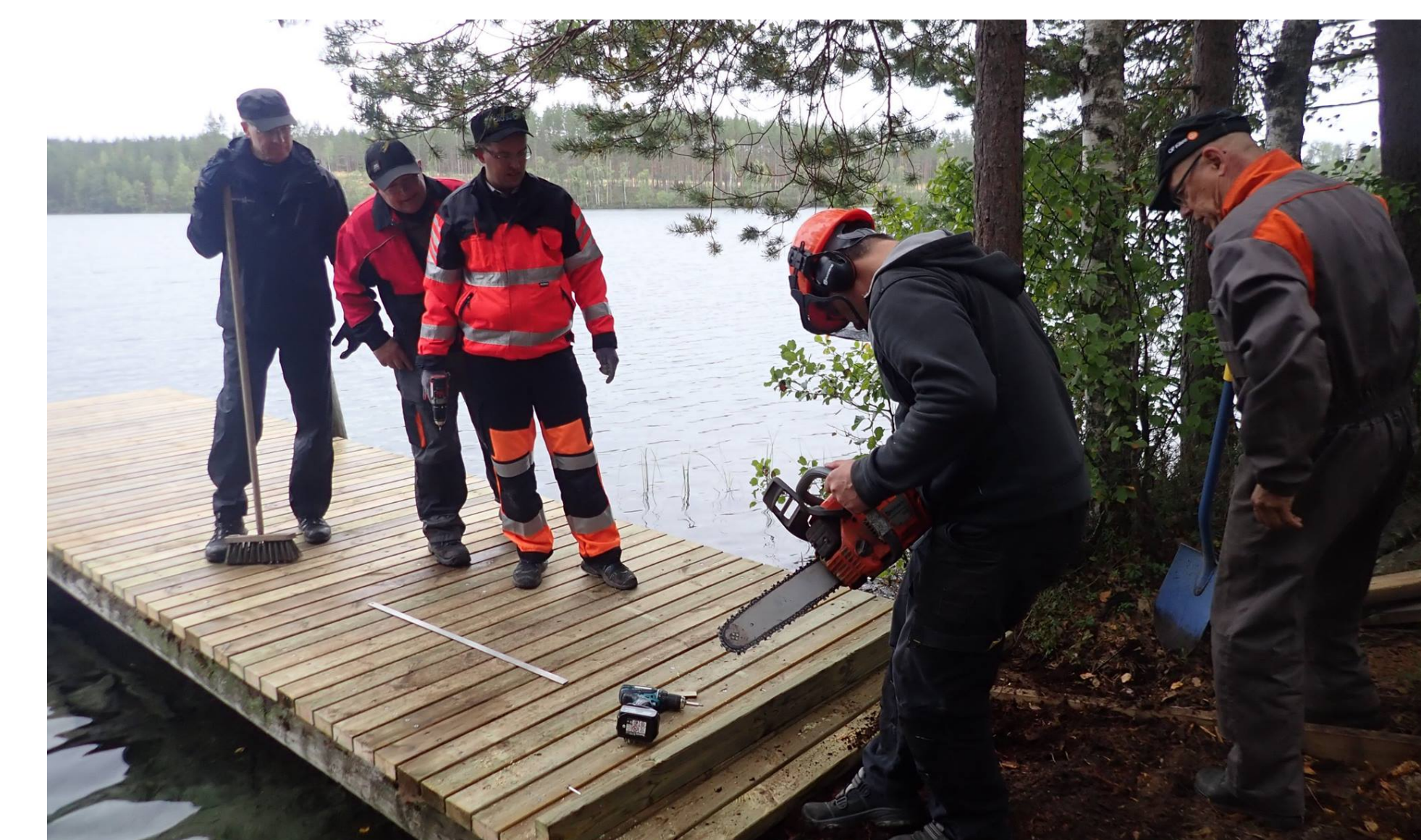
Valkiajärven laituri kunnostettiin kansilaudoituksen osalta.
