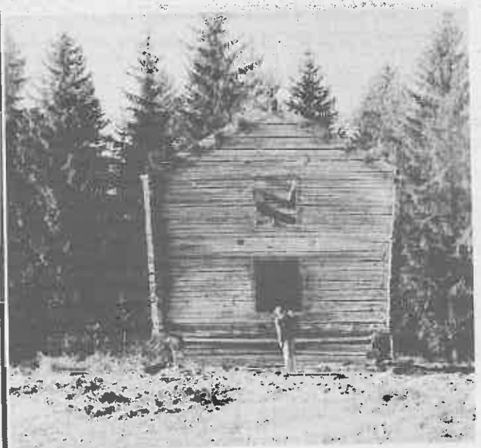
Muhkean muotoinen ja suurikokoinen vilja-aitta Reipin alueelle koottuna. Rakennus oli kuvanottohetkellä vielä ilman vesikattoa ja ovia.
