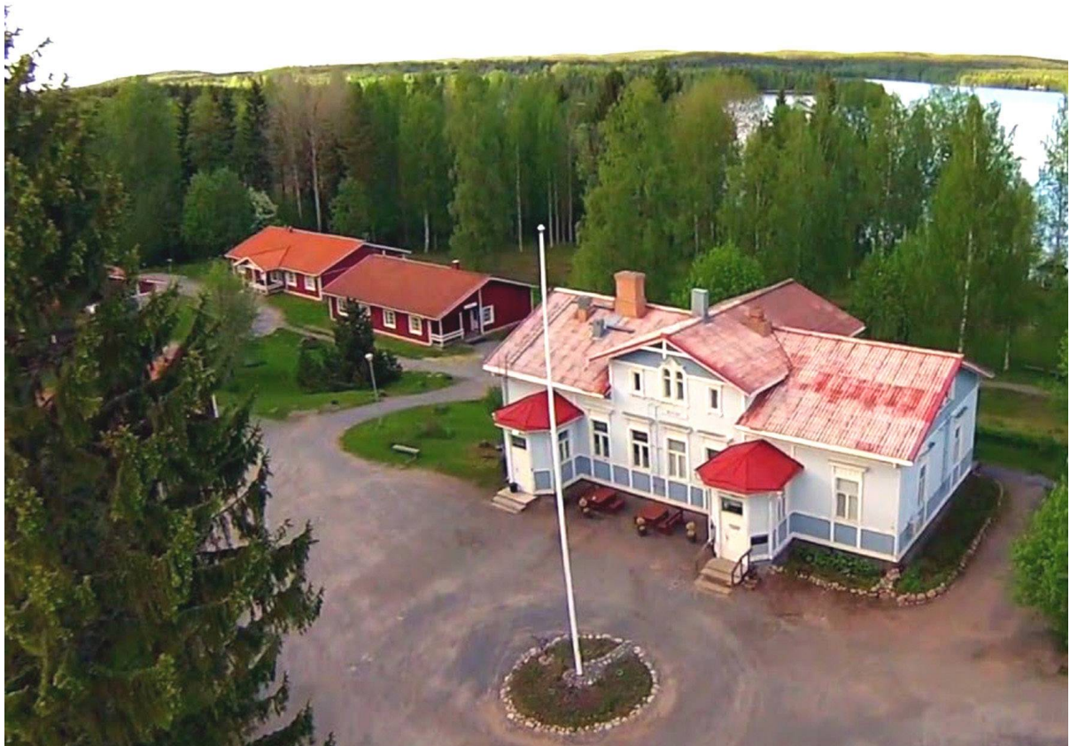
Piirin kesäpäivien pitopaikka Rajaniemen lomakeskus internetistä pimitussa ilmakuvassa. Edessä päärakennus ja vasemmalla rivitalo Pehtorin Pirtti ja Mäkitupa.
