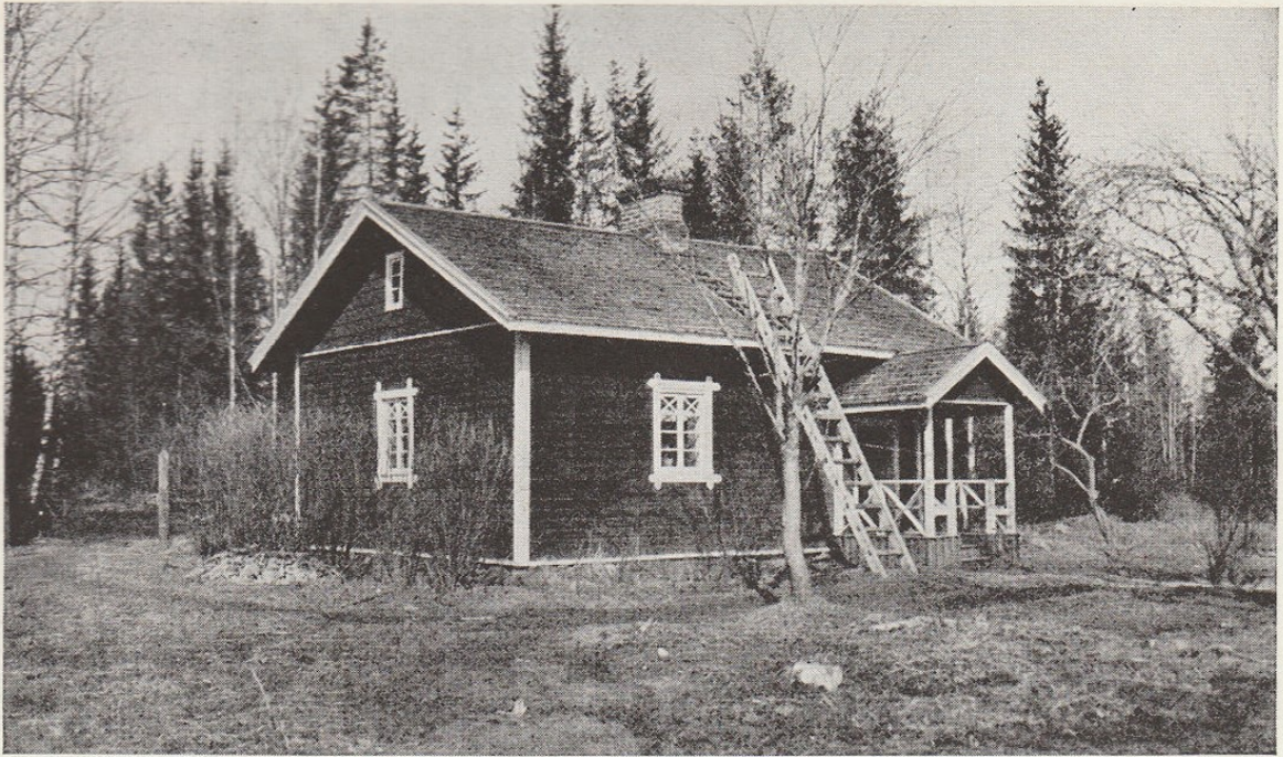
Uudelleen rakennettu Kivimäen torppa
