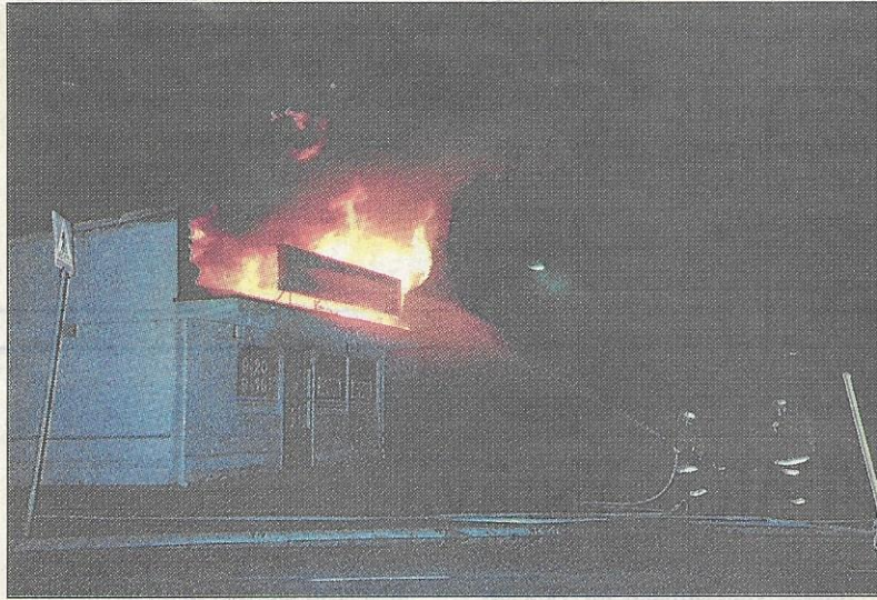
Talon ylärakenteet tuhoutuivat palossa täysin.
