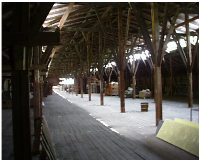
Laatikkotehtaan varaston sisätillaa
