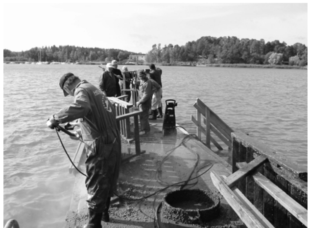
Näkit poistettiin krapalla ja painepesurilla
