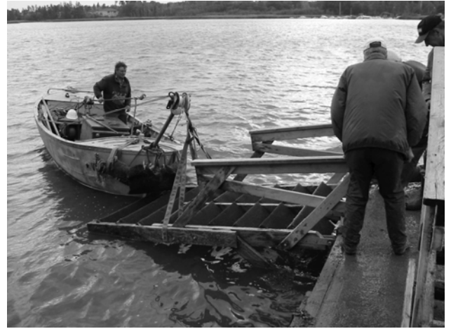
Vega'n avulla, kunnostettu porras laskettiin takaisin paikalleen
