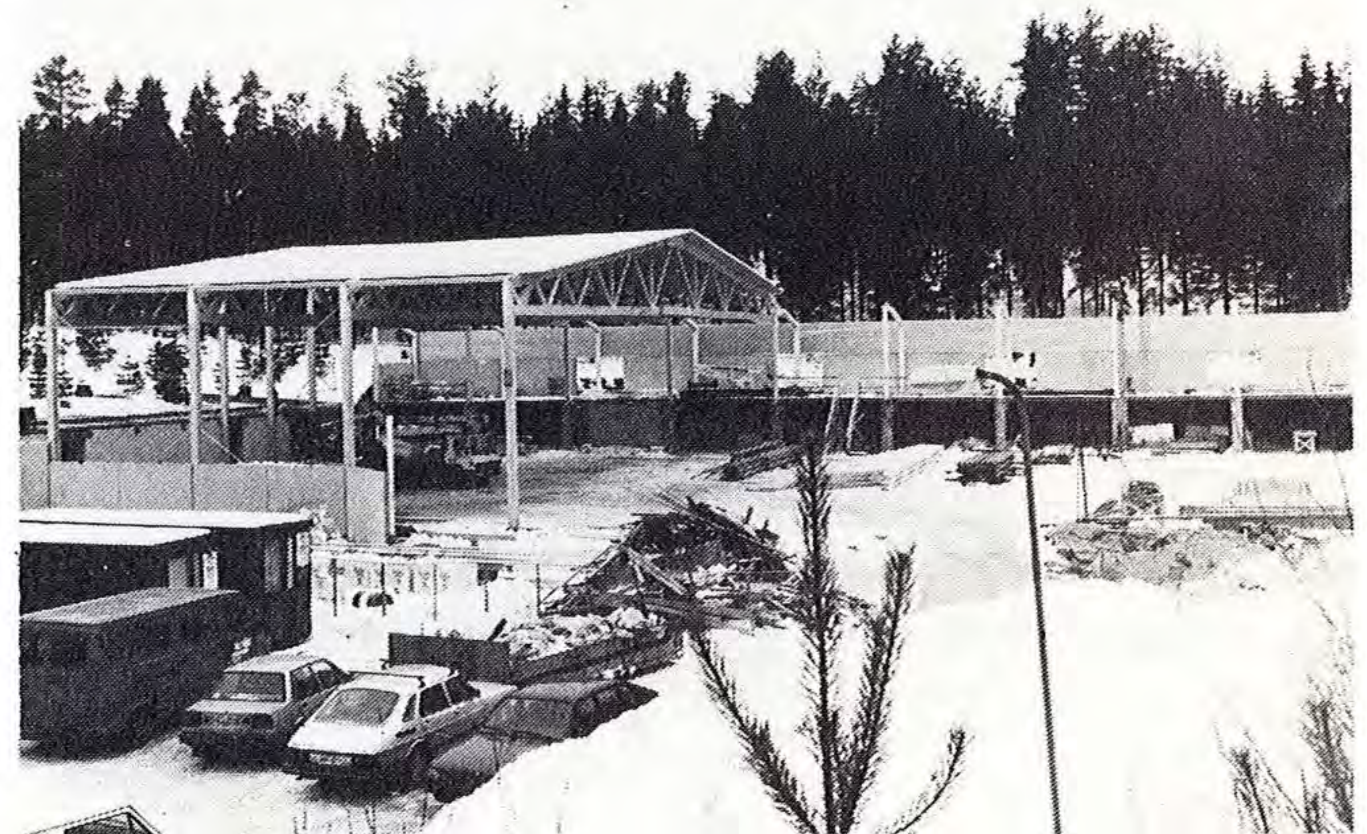
Monien vuosien odotuksen jälkeen Hyvinkäälle kohoamassa oma jäähalli.
