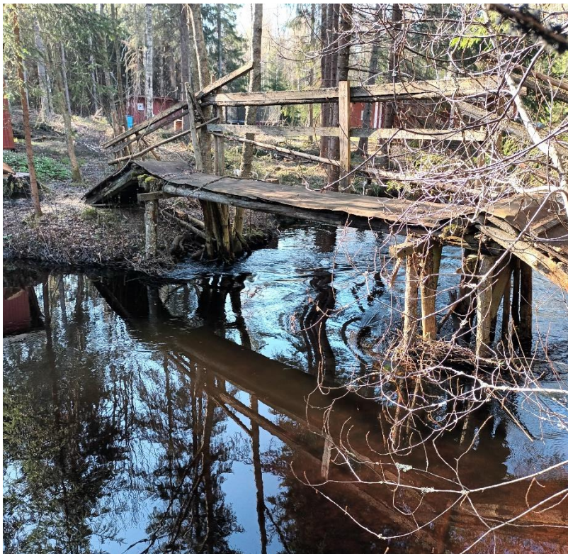
Kuva 18. Silta Renkajoen yli Veittijärven puron kohdalla.
