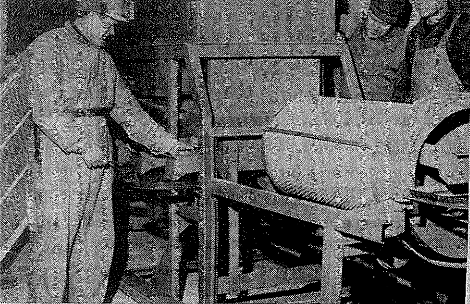
Koneen asennukset käynnissä Juurevan myllyllä
