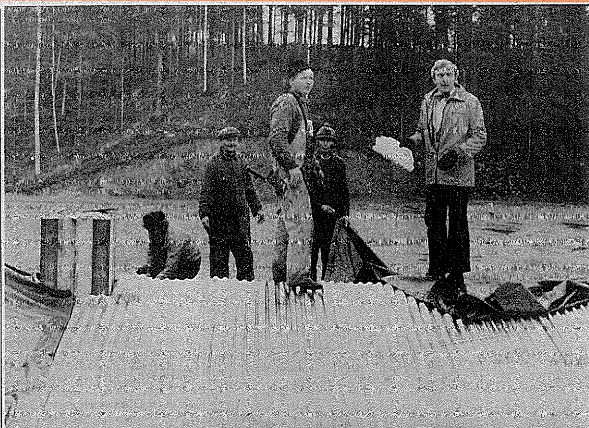
Kuvassamme jääkiekkojaoston puheenjohtaja Aaro Kortetmäki tarkastelee hyvään vauhtiin edistyneitä huoltorakennuksen rakennustöitä.
