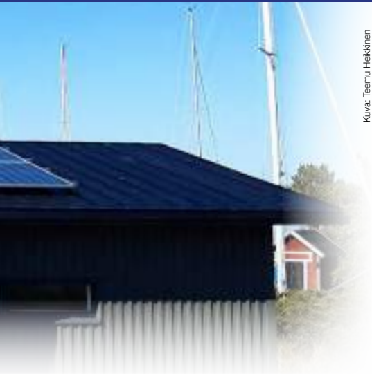
Kuva 1. Kuvassa Kylmäpihlajan saunarakennuksen katolle asennettuja aurinkopaneeleja tuottamassa sähköä.
