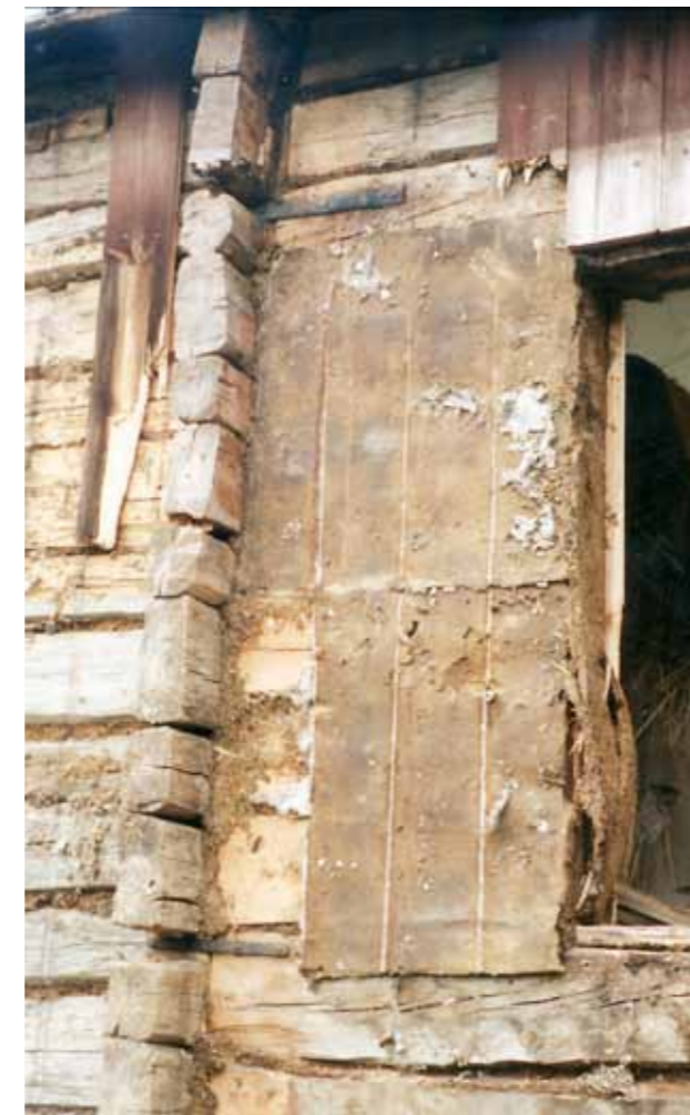
Uusin kehikko, Itäinen kamari, oli kiinnitetty keittiöosaan lattaraudoin. Kuvassa näkyy raudoista kaksi.
