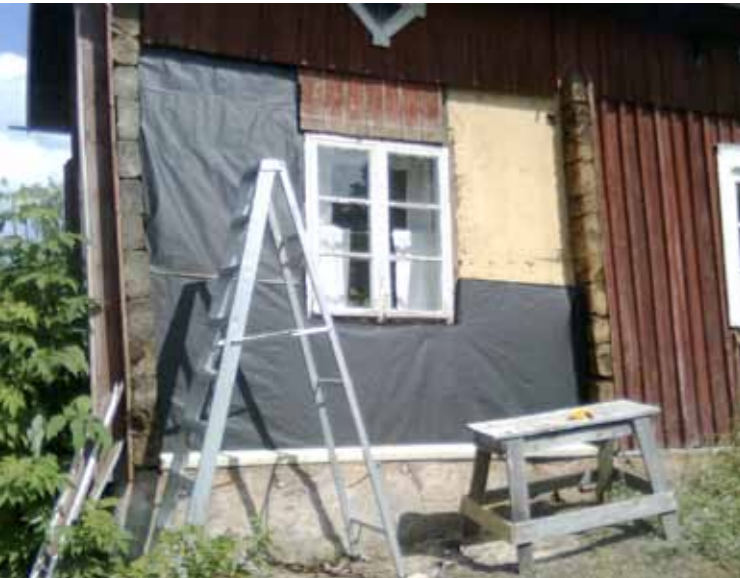
Laudoitus aloitettiin torpan kamarin seinustalta.
