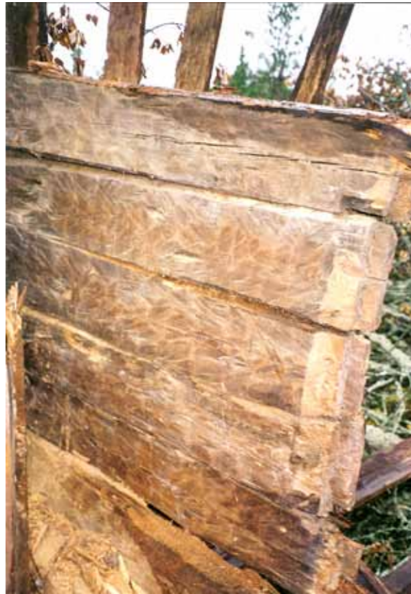
Salin seinähirret olivat kirveellä veistetyt.
