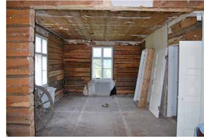
Kaikki pinnat avattiin aina kattojen Haltex-levyjä myöden. Kaikki alkuperäiset pinnat paljastettiin esiin.
