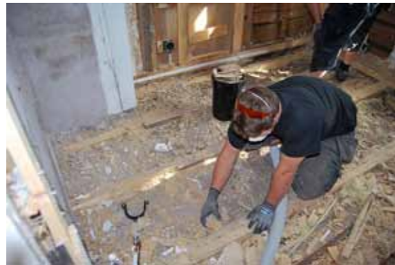
Viemäriputkien kulkusuuntia jouduttiin etsimään "käsikopelolla".
