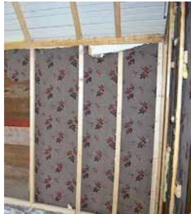
Entisestä kokoushuoneesta poistettiin lasivillaeristeet ja rakennusmuovit. Alta paljastuivat 1930-luvulle tyyppilliset tummahkot kukkatapetit. Todennäköisesti tapetit olivat vuoden 1932 remontin ajoilta. Yläkertaan saatiin rauhalliset, raikkaat ja kauniit huoneet.
