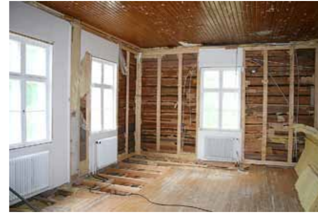
Tulevassa keittiössä seinien koolaus oli tarpeen kaappien asennusta varten, muuten hirsiseinät vain maalattiin vaaleiksi.
