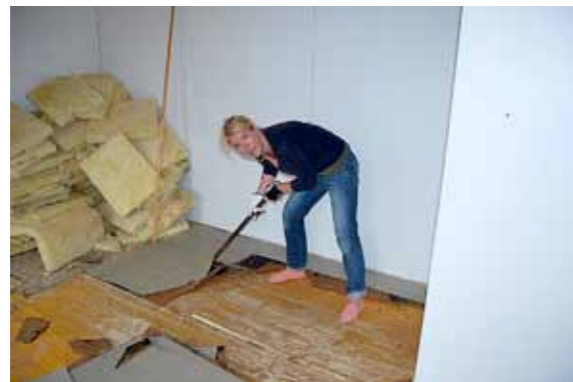
Jaana tarttui tarvittaessa remonttiin itse. Lapiolla oli käyttöä vanha linoleumimaton purkamisessa.
