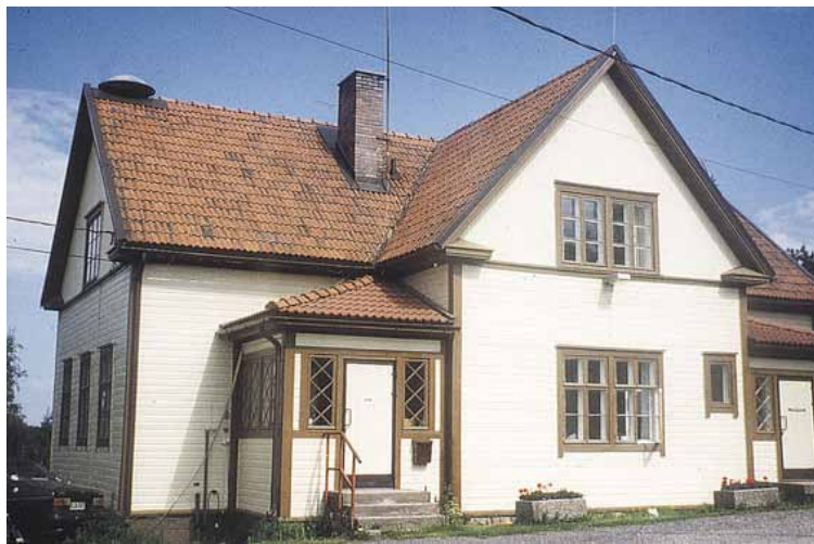
Kunnantalon yhteydessä olleeseen Osuuspankkiin kuljettiin vasemman puoleisesta ulko-ovesta.
