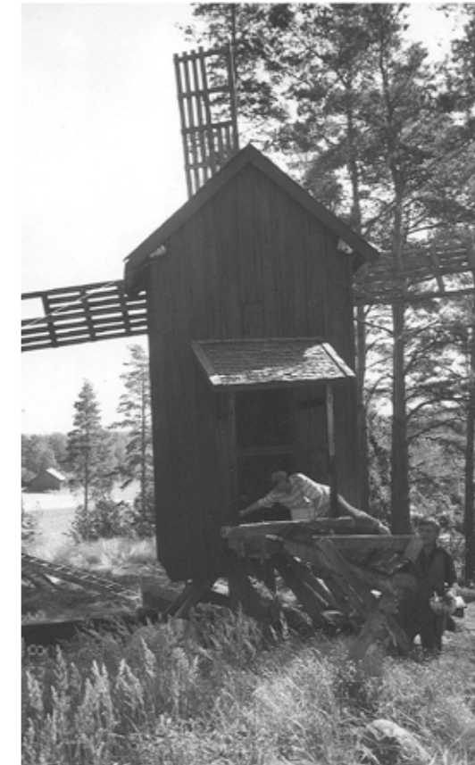
Mylly on jo saanut punamullan seinäpintoihin ja räystäslautoihin. Muut puuosat viimeistellään tervaamalla. Tervaaamassa Antero Lehtonen taustalla ja Heikki Randell etualalla.
