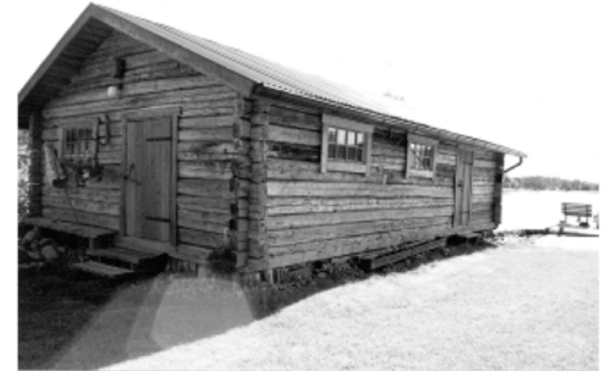
Venevaja, kuten muutkin pihapiirin vanhan oloiset rakennukset on rakennettu vanhan, puretun rakennuksen hirsistä
