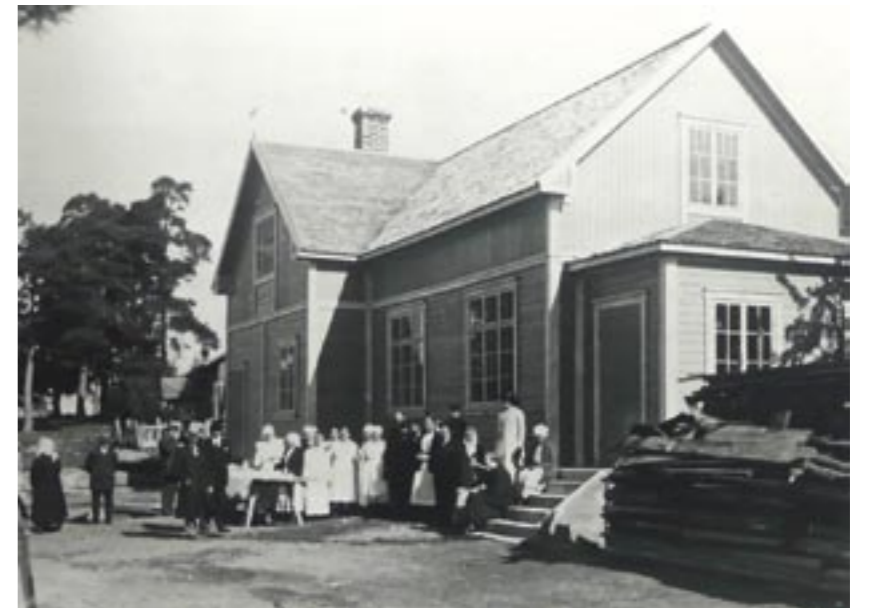
Merimaskun rukoushuone. Pihamaalla lähetysjuhlien väkeä. Kuva on rukoushuoneen peruskorjauksen jälkeen, koska oikeassa reunassa näkyy vielä korjauksen jäljiltä jäänyttä purettua rakennusmateriaalia.
