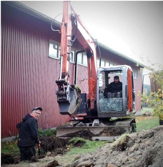
Veljekset Antti ja Jaakko rakentamassa lämpölinjaa uuteen halliin syksyllä 2021.
