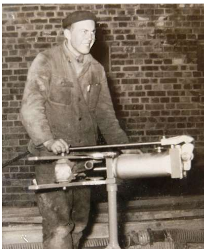
Runo Aaltonen ja putkentaivutuskone.
