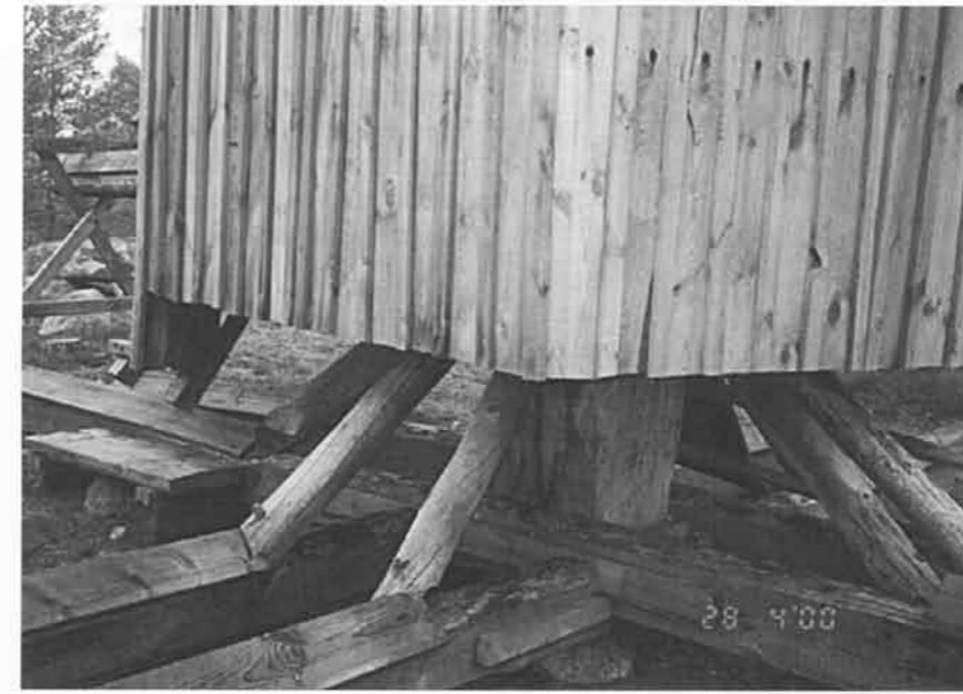
Jalkamyllyn "kontti" tuettiin alushirsiin "varpailla"
