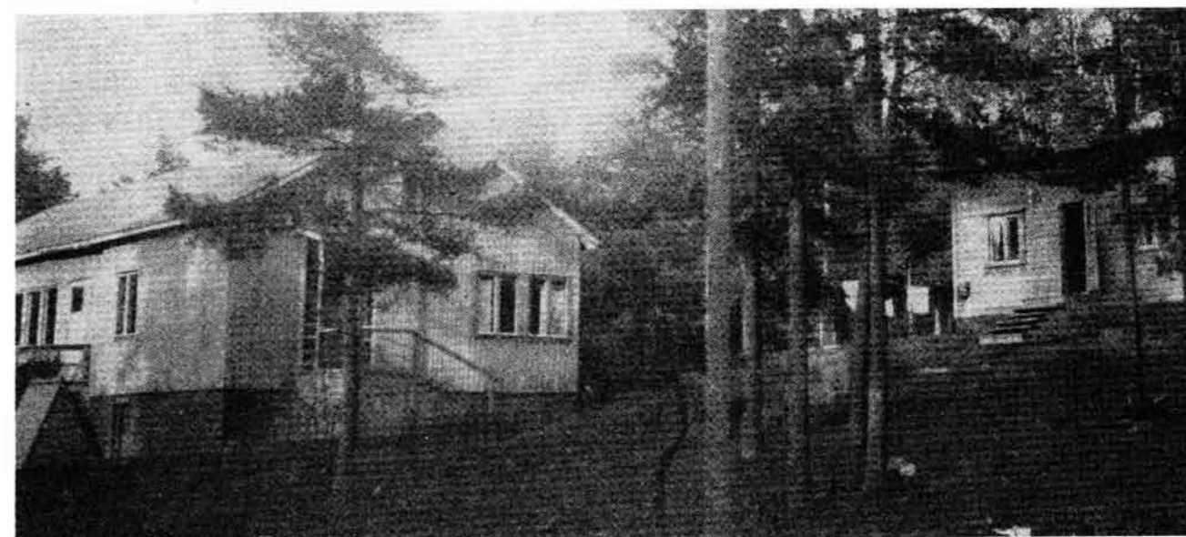
Seivästön Osuuskauppan jälleenrakennettu päämyymälä.
