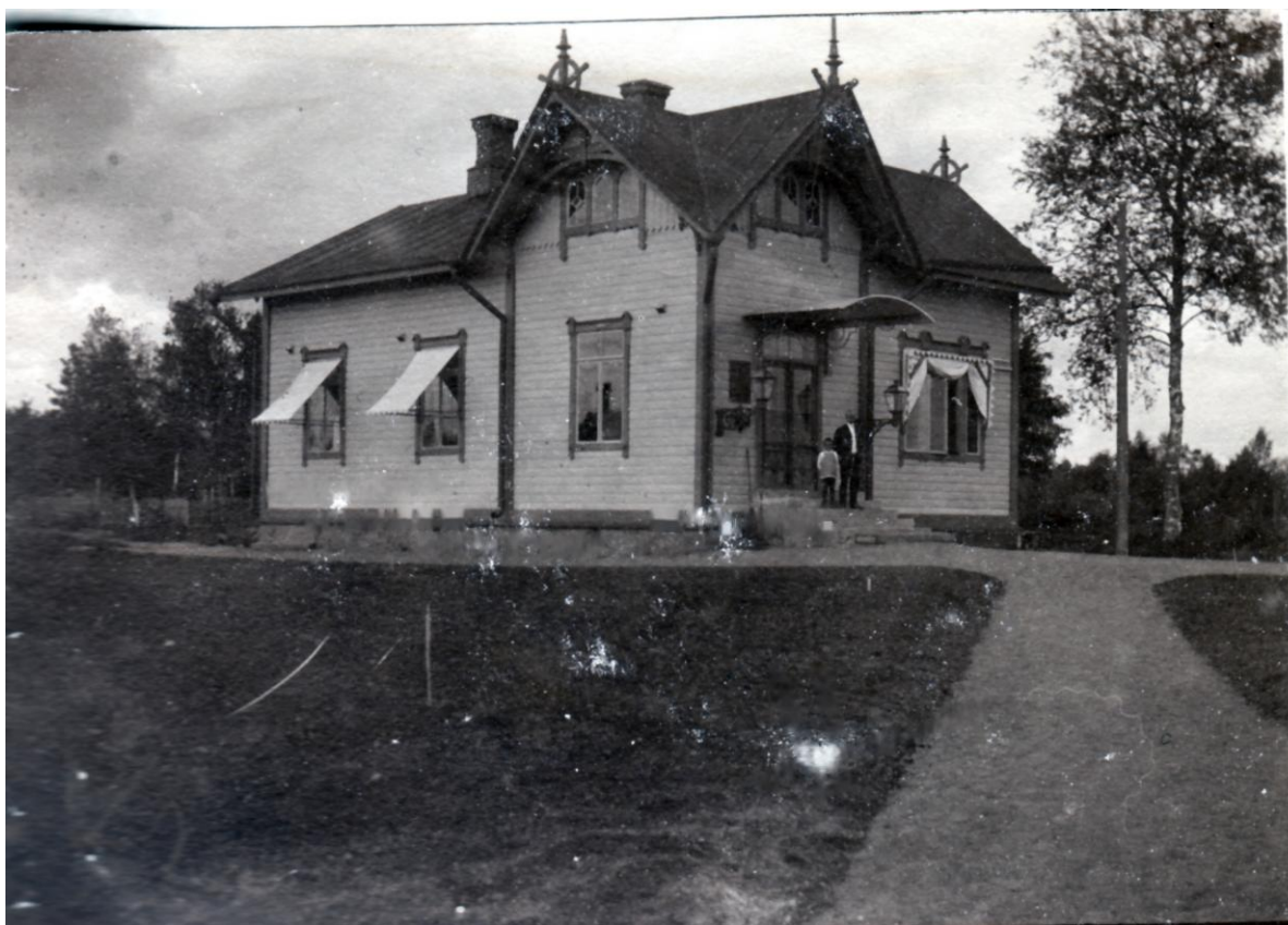
Tammisuon pysäkin asemarakennus alkuperäisessä koossaan.
