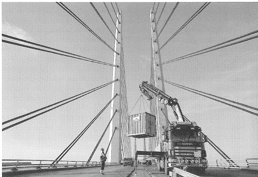
Hiab-nostureita käytettiin menestyksekkäästi Ruotsia ja Tanskaa yhdistävän Öresundin sillan rakentamisessa
