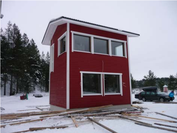
Rakennus saatiin ulkopuolelta valmiiksi 14.11.2010.
