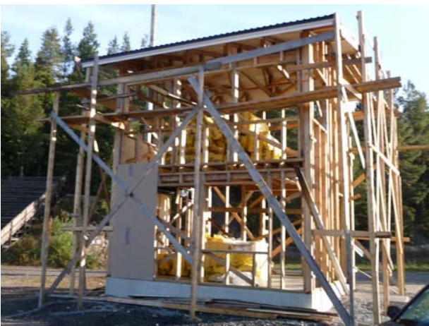
9.9.2010 katto päällä ja seinien levytys aloitettiin.
