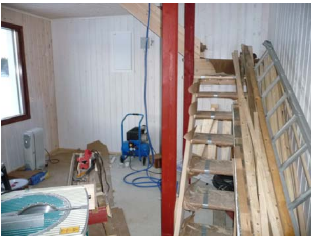
Sisätiloissa alkaa näyttää valmiilta (24.11).
