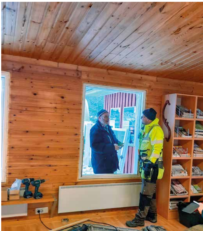
Ikkunat toimitti ja asensi Tapijola-ikkunat. Kuvassa työtä seuraa Kari Liimatainen.
