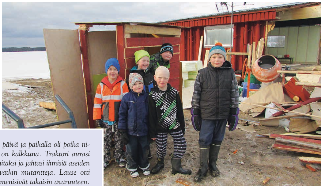
Pojat rakensi oman taukomökin Pavin työmaalle!
