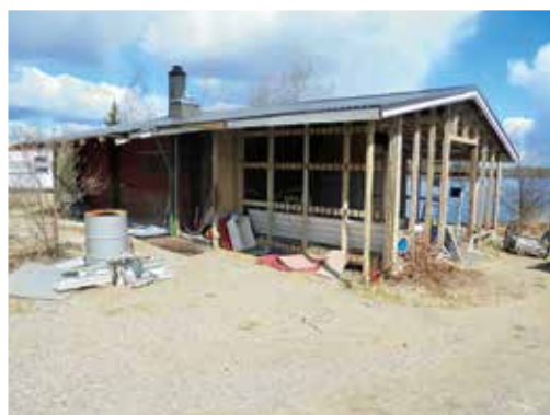
Purku aloitettiin jo hyvissä ajoin toukokuussa, sauna kuitenkin käytössä.
