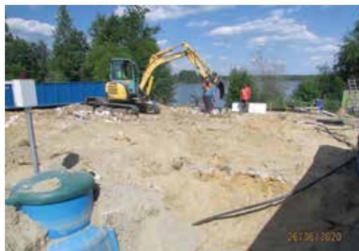
Saunan purku tehty 26.6. Viimeinen perustuksen murikka lähteen traktorin kauhaan. Hietasaaren talkooväki teki taas uskomattoman työsuorituksen. Puretuksi tuli saunan lisäksi traktoritalli ja varastorakennukset.
