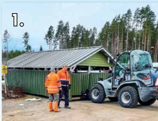
1. Kraamerilla vedettiin entinen jätekatos kokonaisena rannalle odottamaan niemen kuivumista. Katos tulee palvelemaan varastona kesäsaunan läheisyydessä.
