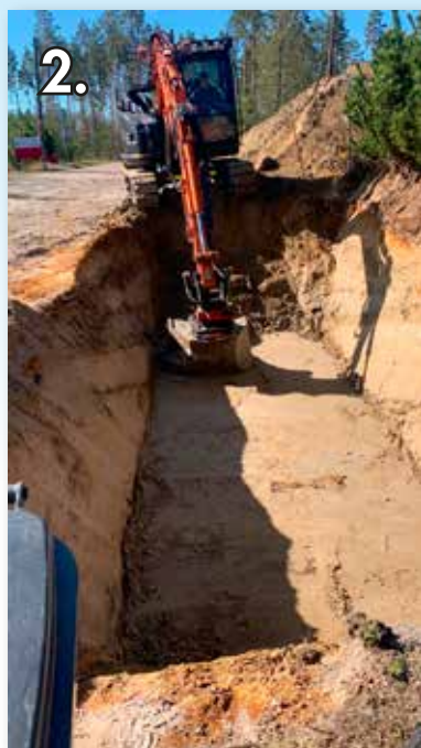
2. Jäteastioiden tarvitsema maakuoppa kaivettiin tulotien suuntaisesti.
