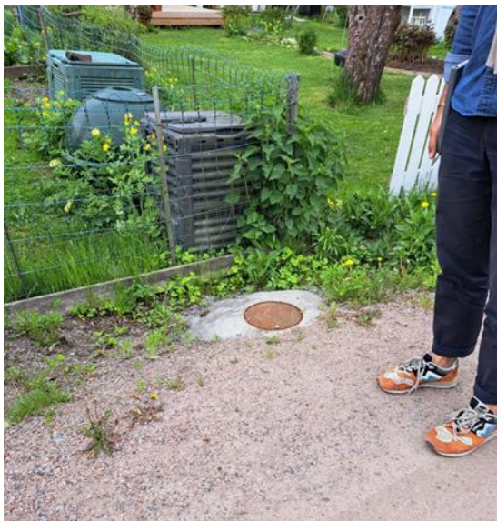
Kuva 6. Kumpulan siirtolapuutarhalla sijaitsevan salaojakaivon kansi tiivistetty käsin muotoilulla betonivalulla.
