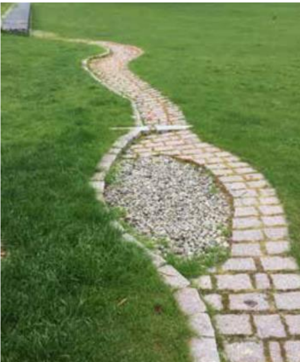
Kuva 4. Imeytyskaivanto Kirjastopuistossa Vantaalla. Kuva: Viheralueiden luonnonmukaisten hulevesirakenteiden kunnossapito (2022)
