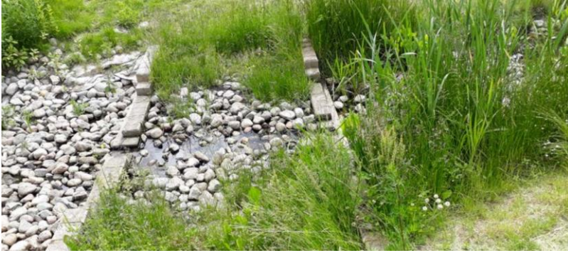
Kuva 3. Viivytyispainne/avoin hulevesiuoma, jossa käytetty luonnonmateriaaleja, puuta ja pyöreitä luonnonkiviä sekä vesikasvillisuutta. Kuva: Espoon hulevesiohjelma (2020)
