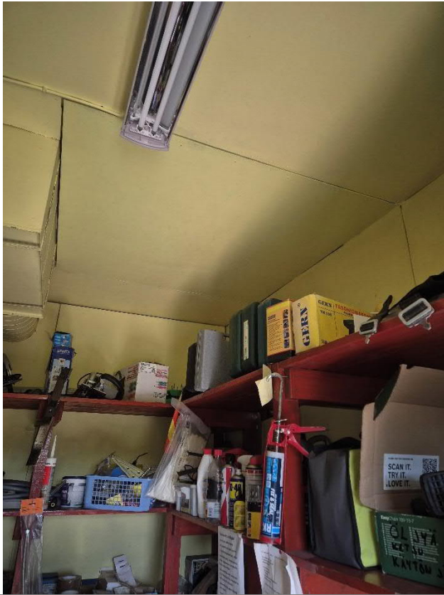
Kuvat 5 ja 6. Tutkimuksessa irrotettiin yksi kattolevy. Kattolevyn takana havaittiin yläpohjan eristeet.
