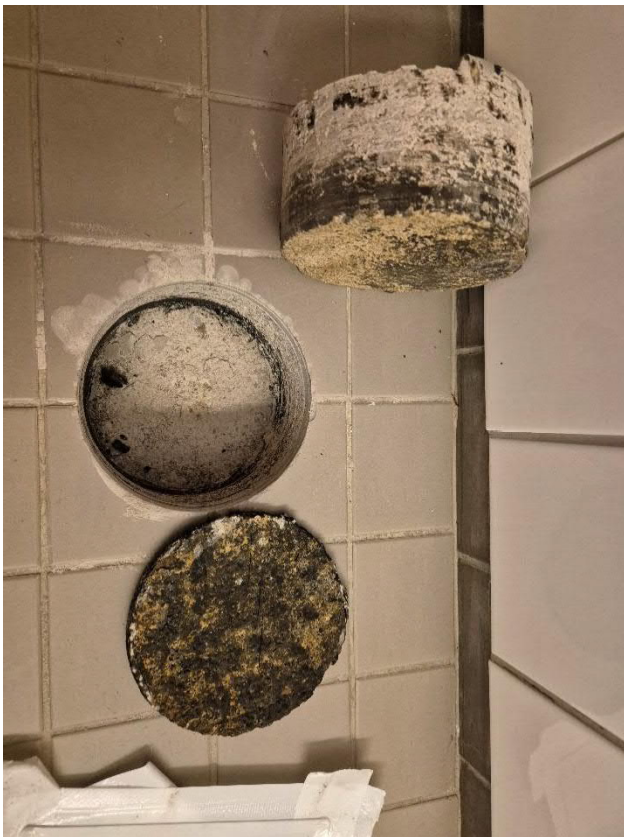
Kuva 15. Märkätilan pintalaatan alla havaittiin bitumikermi vedeneristeenä. Kyseinen bitumikermi ei sisällä asbestia tai PAH-yhdisteitä.
