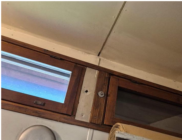
Kuvat 11 ja 12. Ikkunoiden välissä on puulaudan takana sementtilevyä. Ikkunan yläpuolisen sementtilevyn takana ei havaittu toista sementtilevyä.
