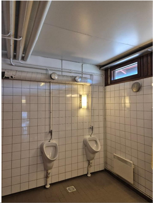
Kuvat 1 ja 2. Märkätilojen laatoituksissa ei havaittu asbestia. Seinissä ja katossa on kuitenkin asbestipitoista sementtilevyä.
