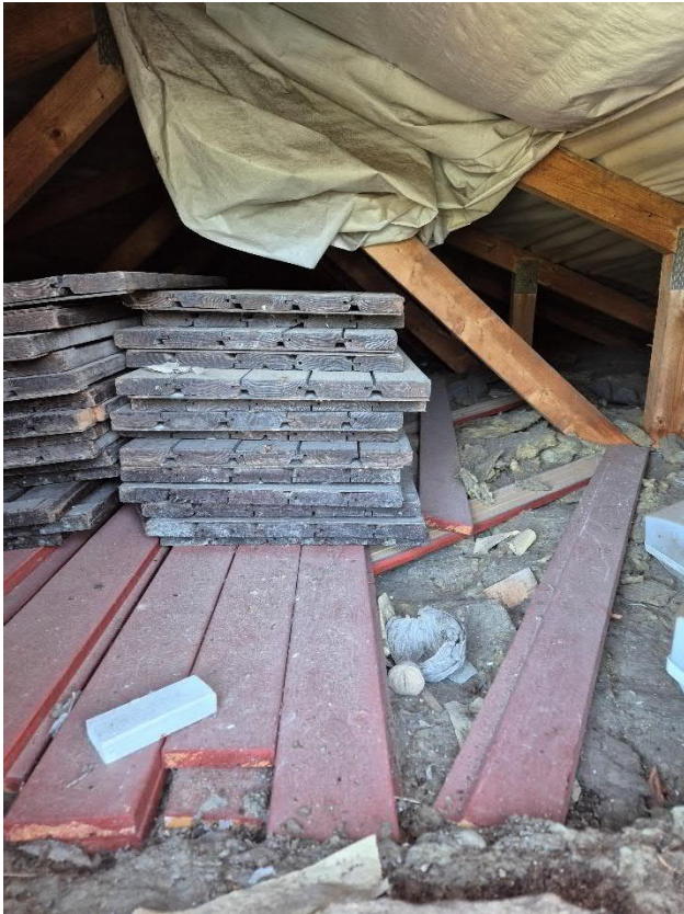
Kuvat 17 ja 18. Yläpohjassa on puurakenteita. Villaeristeen alla havaittiin muovi sekä sementtilevy (huonetilojen katot).
