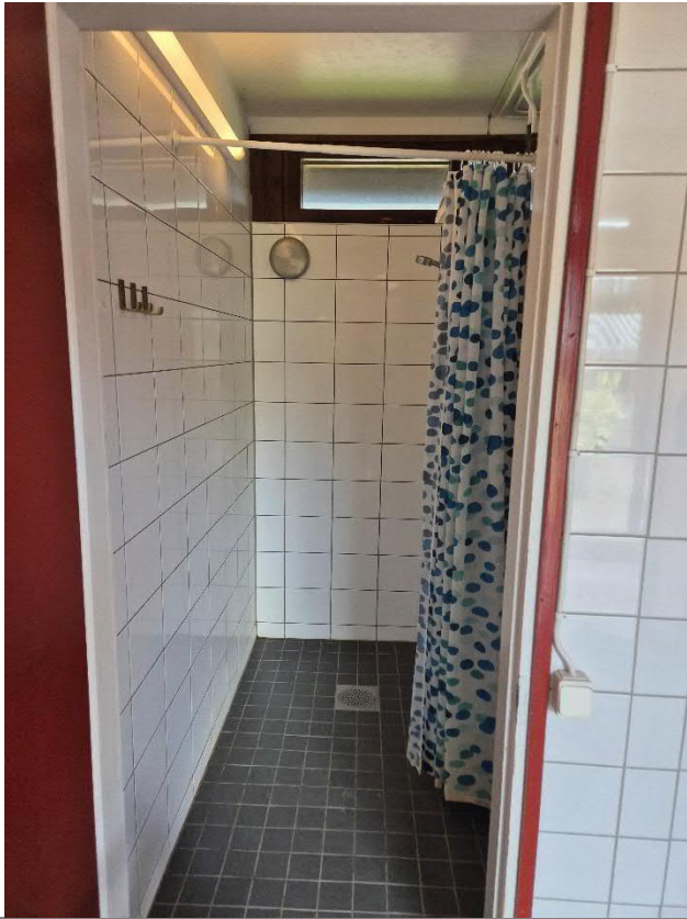
Kuvat 1 ja 2. Märkätilojen laatoituksissa ei havaittu asbestia. Seinissä ja katossa on kuitenkin asbestipitoista sementtilevyä.
