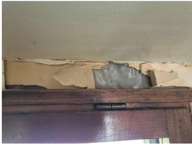
Kuvat 11 ja 12. Ikkunoiden välissä on puulaudan takana sementtilevyä. Ikkunan yläpuolisen sementtilevyn takana ei havaittu toista sementtilevyä.
