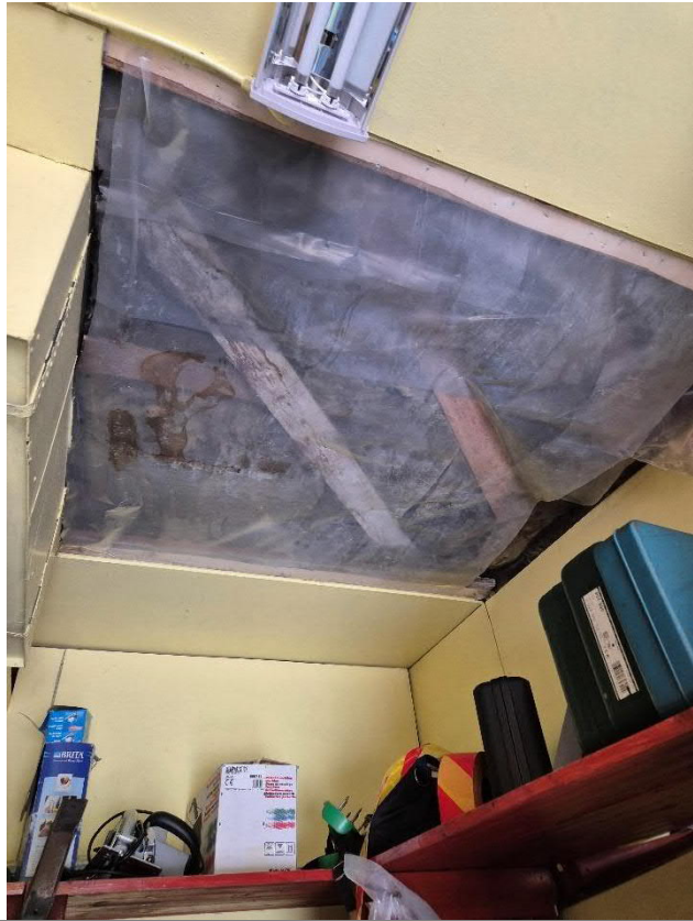
Kuvat 5 ja 6. Tutkimuksessa irrotettiin yksi kattolevy. Kattolevyn takana havaittiin yläpohjan eristeet.
