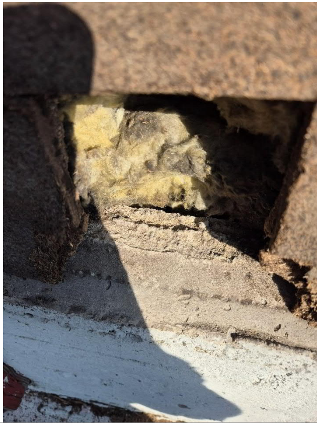
Kuvat 9 ja 10. Julkisivuun suoritetussa avauksessa ei havaittu toista sementtilevyä seinärakenteessa.
