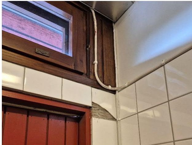
Kuvat 7 ja 8. Laastit eivät sisällä asbestia, mutta niiden takana on asbestipitoista sementtilevyä.
