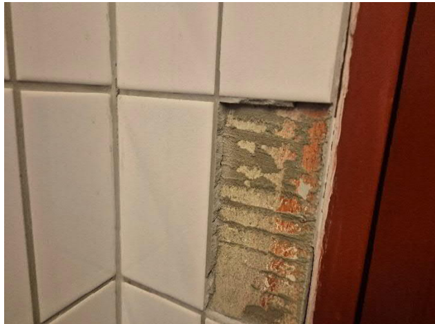
Kuvat 7 ja 8. Laastit eivät sisällä asbestia, mutta niiden takana on asbestipitoista sementtilevyä.
