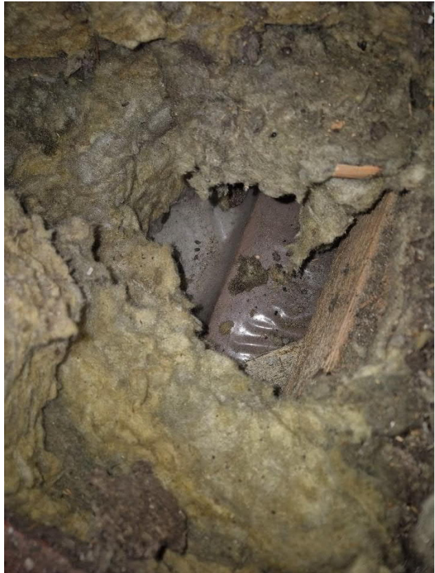
Kuvat 17 ja 18. Yläpohjassa on puurakenteita. Villaeristeen alla havaittiin muovi sekä sementtilevy (huonetilojen katot).
