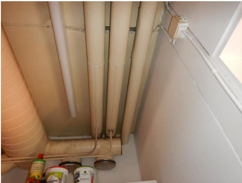
Kuva 36. Yleiskuva käyttövesiputkien asennuksista.
