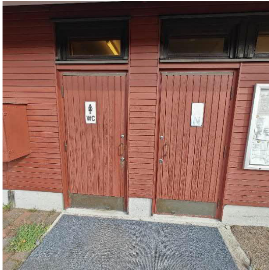
Kuva 23 ja Kuva 24. Ulko-ovien puuosat ovat kuluneita ja maalipinta hilseilee. Lähes kaikki ovet ovat vinossa ja tästä syystä ovien ja karmien välissä on rakoja.
