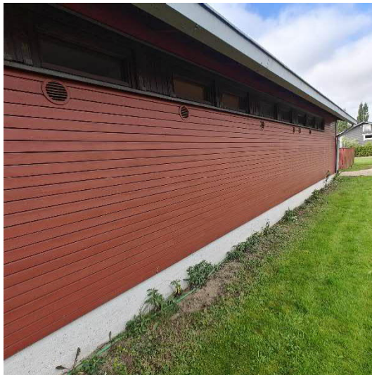
Kuva 14 (vasen). Yleiskuva rakennuksen pohjoisjulkisivusta. Pohjoisjulkisivun laudoituksen maalipinta on suhteellisen hyvässä kunnossa.
