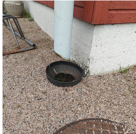
Kuva 6 (oikea). Kattovedet ohjataan loiskekuppeihin, joista osittain roiskuu vesi sokkelirakenteisiin.
