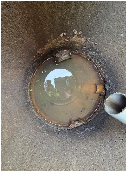
Kuva 7(vasen). Tutkittavan rakennuksen luoteisnurkalla kaivossa putket veden pinnan alla eikä vedet ohjautu purkuputkesta eteenpäin. Salaojajärjestelmä padottaa.
