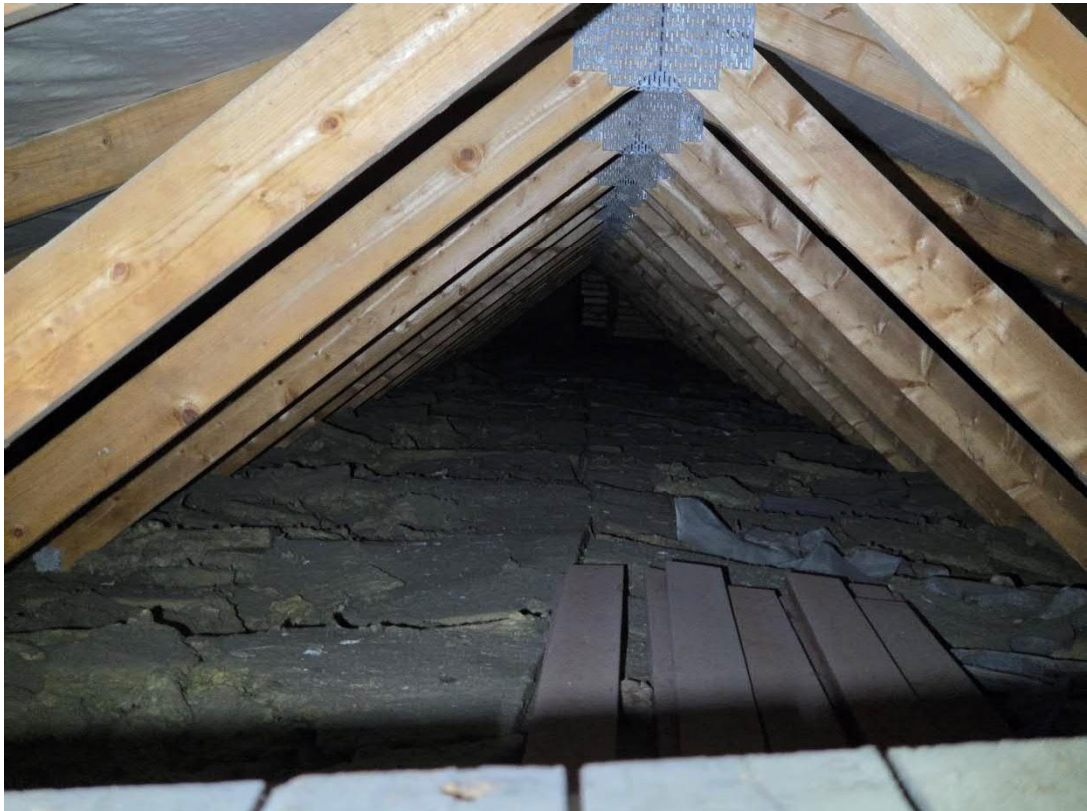
Kuva 30. Yläpohjatilassa kattotuolirakenteet ovat aistinvaraisesti tarkasteltuna hyväkuntoiset, eikä yläpohjassa havaittu merkkejä kosteusvaurioitumisesta. Koko yläpohjatilaa ei kuitenkaan päästy tarkastamaan kulkureitille sijoitetun tavarankuusi. Lämmöneristevillat ovat paikoin painuneet.
