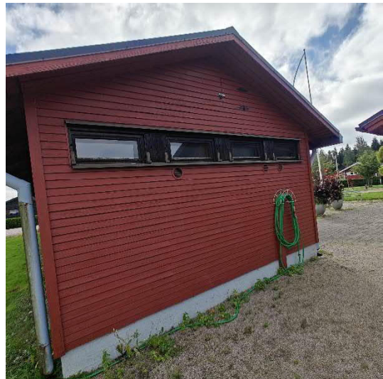
Kuva 14 (vasen). Yleiskuva rakennuksen pohjoisjulkisivusta. Pohjoisjulkisivun laudoituksen maalipinta on suhteellisen hyvässä kunnossa.
