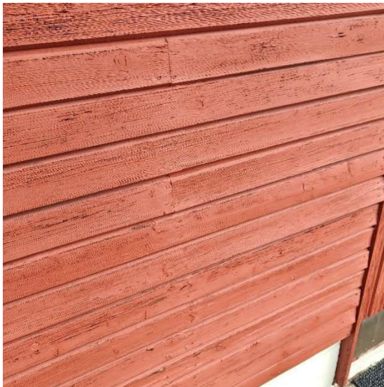
Kuva 16 ja Kuva 17. Eteläjulkisivun maalipinnoitteessa kulumaa ja maalipinnan lohkeilua. Paikoin myös käyrästyneitä ulkolautoja.
