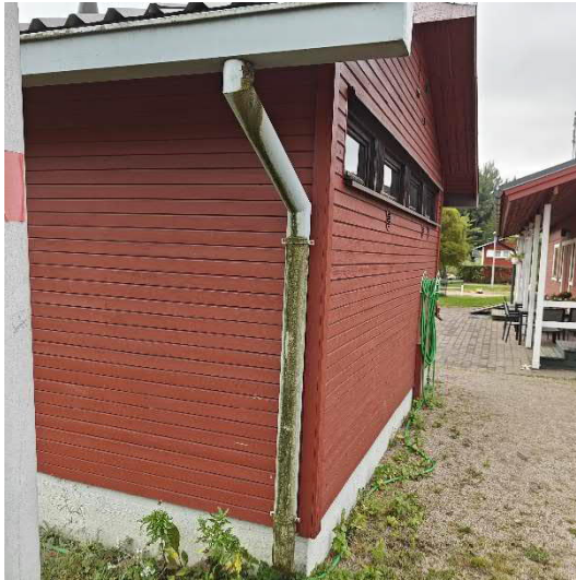
Kuvat 5 (vasen). Yksi syöksytorvi vuotaa.
