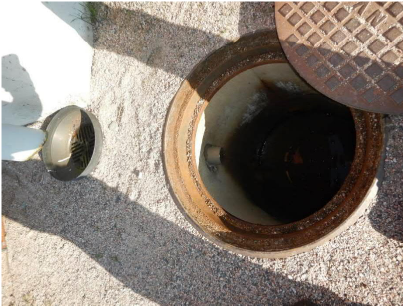
Kuva 43. Rännikaivo vaikuttaa laskevan suoraan salaojakaivoon.
