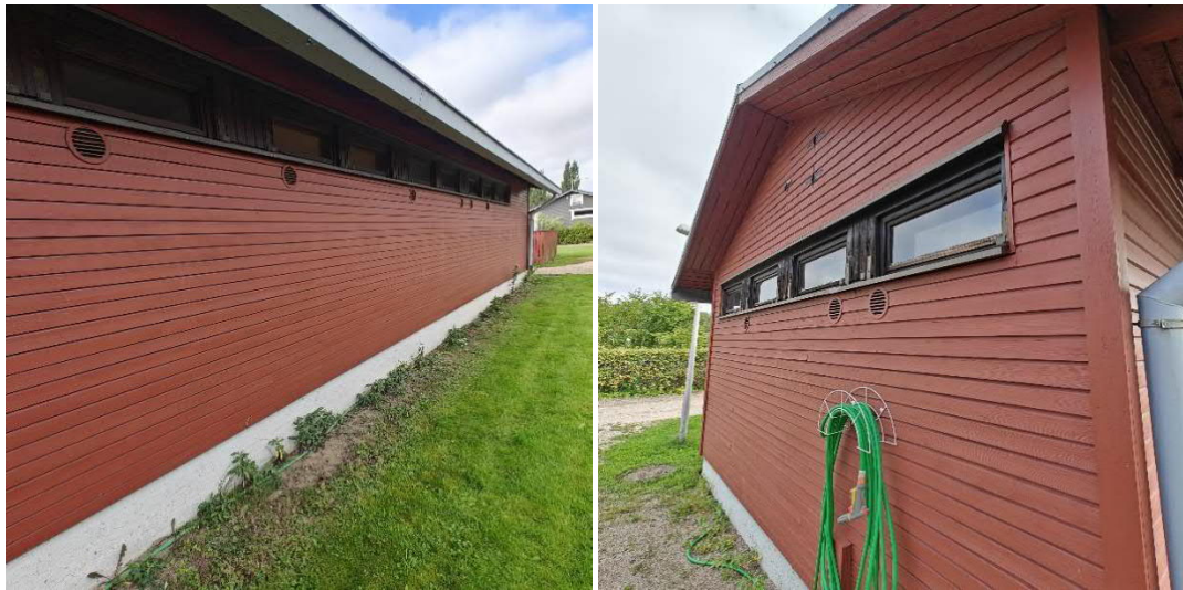
Kuva 19 ja Kuva 20. Yleiskuvaa rakennuksen ikkunoista. Pitkien sivujen ikkunat ovat räystäään alla suojassa. Länsipäädystä ikkunat eivät ole niin suojassa, ja ovat alttiimpia säälle.
