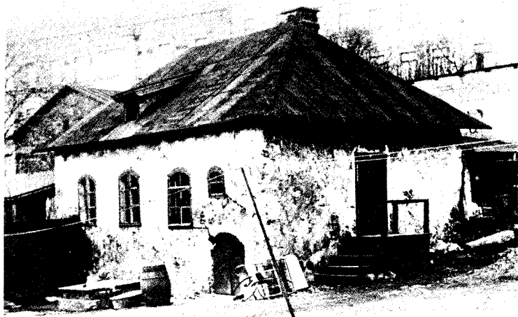
Muuan Viipurin kaupungin vanhimista rakennuksista on tämä keskiaikainen kivitalo, ns. Kiltatupa (Keisarinkatu, myöh. Luostarinkatu 10:ssä). Talon tiedetään olleen käytössä ainakin jo vuonna 1445. Valok. J. Vikstedt (kirjasta Vanhaa rakennustaideitamme vltta 1958).
