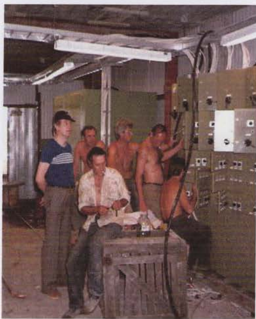
Säätöilmavaraoston sähkötyöt käynnissä Taganrogin varastolla
