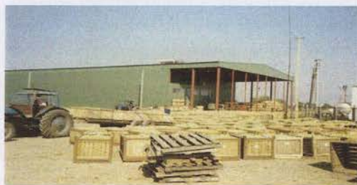
Hedelmäsovhoosi Taganrogin 3000 tonnin säätöilmavarasto omenan pitkäaikaisvarastointiin.
