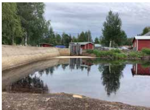
Saha ja mylly paloivat kesällä 2004. Tilalle on rakenteilla voimalaitos ja mylly.
